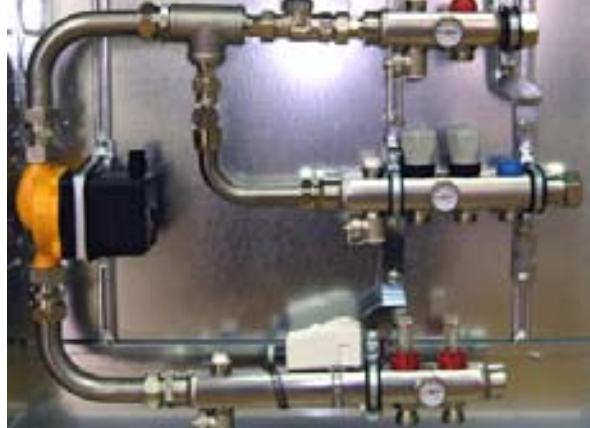
Slika 137. Razdjelnici za centralna grijanja tvrtke Thermotechnik
