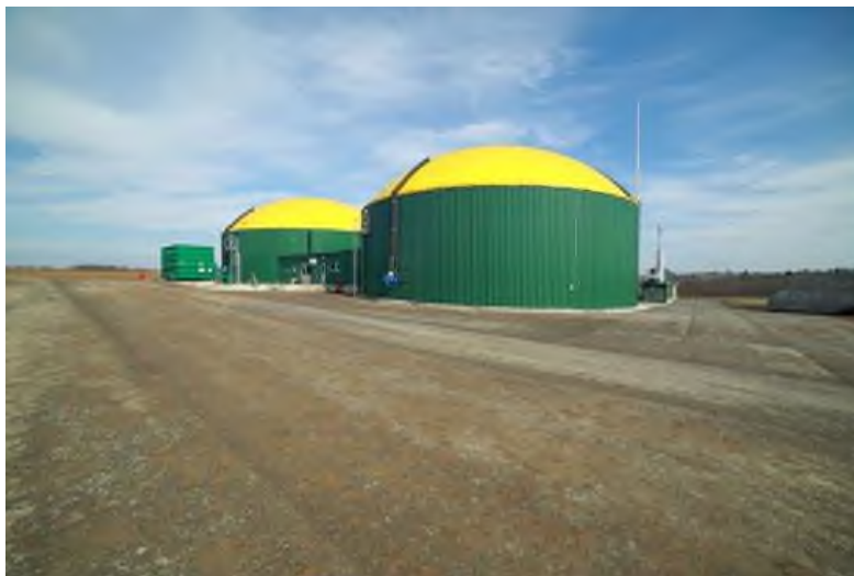
Slika 46.: Bioplinsko postrojenje - fermentori
