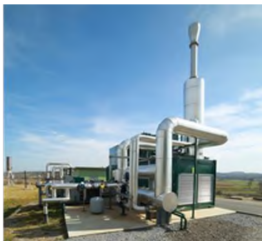
Slika 47.: Bioplinsko postrojenje - kogeneracijska jedinica
